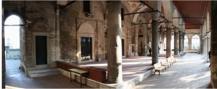
Resim 8. Son cemaat yeri ve çatı örtüsü
